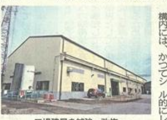
工場建屋を補強・改修
