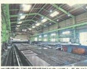
工場構内(天井照明灯はすべてLEDに)
