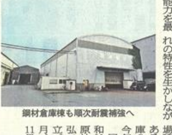
鋼材倉庫棟も順次耐震補強へ
