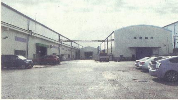
耐震補強工事、外観のリニューアルなどを行った工場・倉庫
