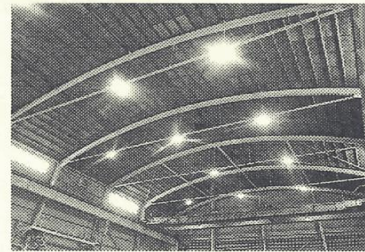
建物構造を補強①と天井照明もLED化
